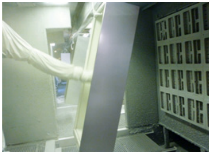
Mauser Einrichtungssysteme beschichtet sein Teilesepektrum u.a. in zwei Roboterlackierkabinen. Mit der Druckluftaufbereitung wird bei komplexen Geometrien eine bessere Eindringtiefe in Ecken und Kanten erzielt.
