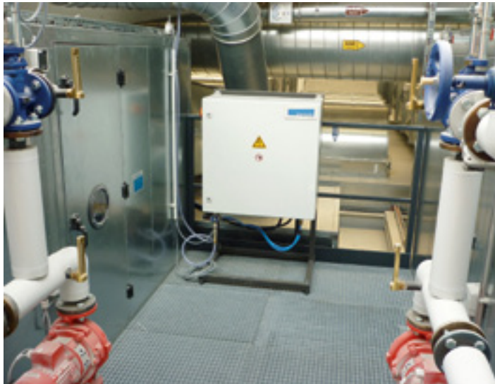
Die Anlage zur Ionisierung und Erwärmung der Zerstäuberluft lässt sich schnell und einfach montieren. Quelle (drei Fotos): ensutec
